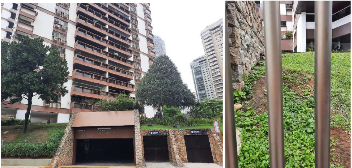
Figura 135: Entrada do condomínio.
