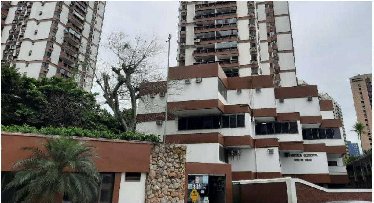
Figura 139: Fachada da escola municipal Golda Meir.
