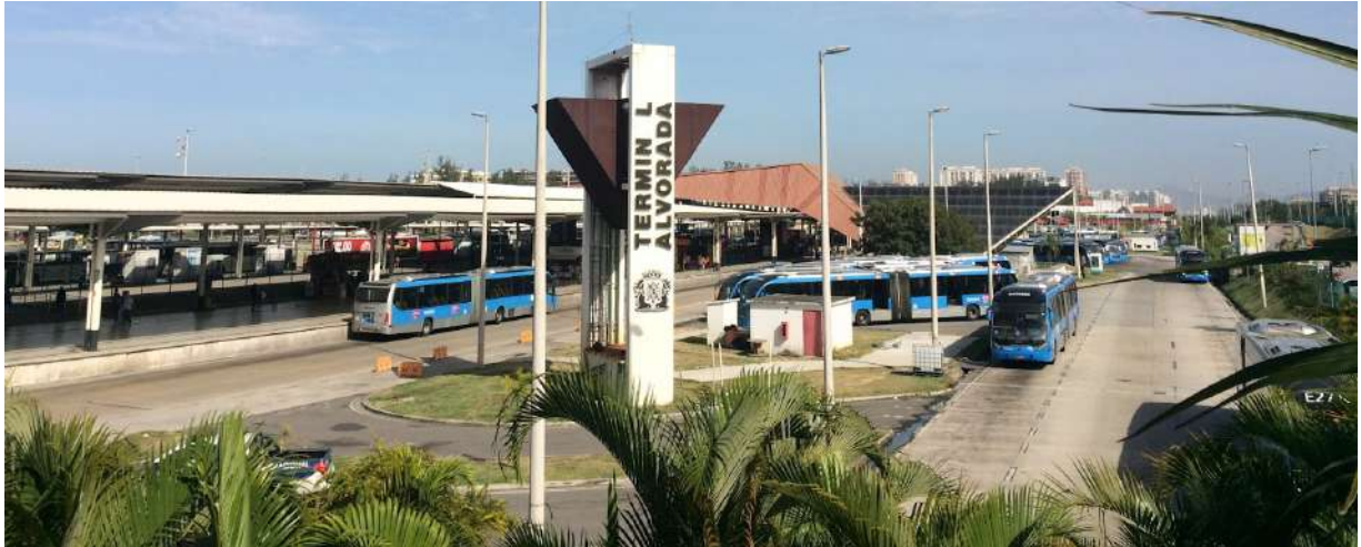
Figura 57: Terminal Alvorada. Fonte: Autora (2019)
