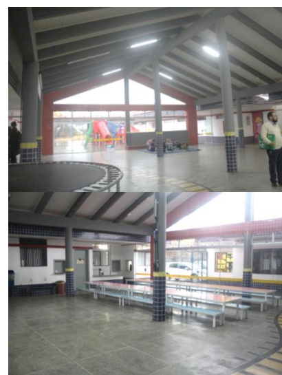
Figura 21 – Pátio coberto e refeitório. Fonte: Autores, 2016.
