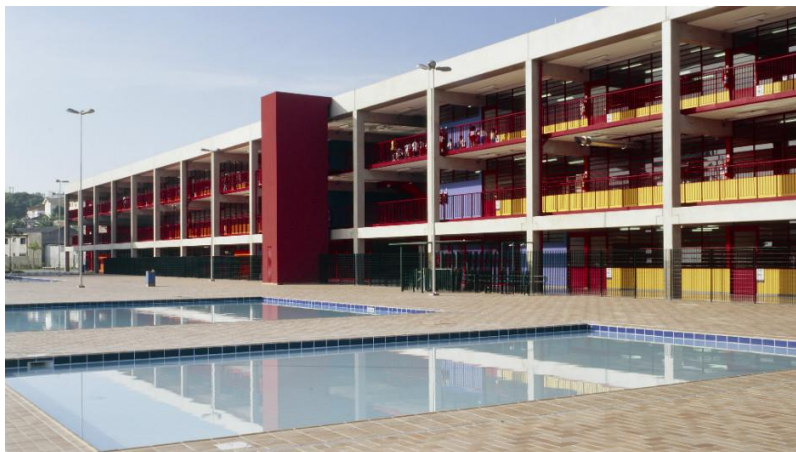
Figura 22: Centro Educacional Unificado - CEU Fonte: Na Prática.org 22
