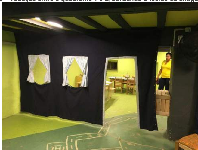
Figura 146 – Vedação entre o quadrante 1 e 2, utilizando o tecido da antiga cabaninha.
