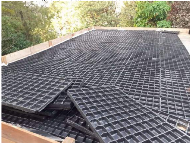
Figura 161 – Sistema drenante do telhado verde
