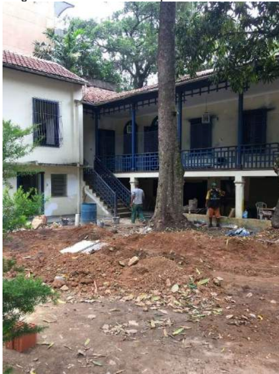
Figura 62 – Chão de terra do pátio durante as obras
