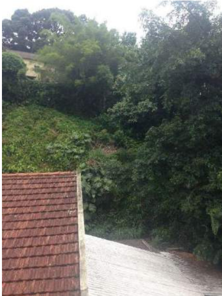
Figura 37: Acréscimo irregular com cobertura metálica e terreno livre em aclive ao fundo.
