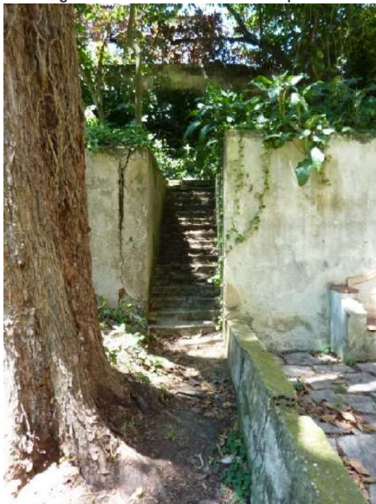
Figura 106 – Escada de acesso ao platô 3.
