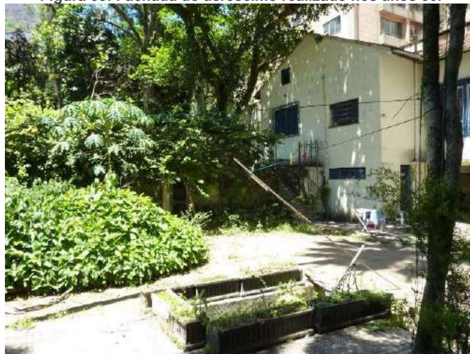
Figura 58: Fachada do acréscimo realizado nos anos 50.
