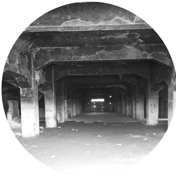
Figura 44: Estrutura interna do silo, pavimento térreo. FONTE: Autor, 2018.
