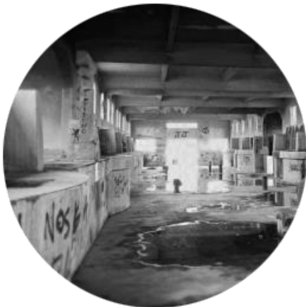
Figura 48: Estrutura interna do silo, 2º pavimento. FONTE: Sociedade Militar, 2019.
