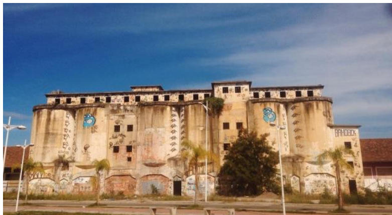
Figura 12: Silo de Manguinhos, onde será feita a maior parte das intervenções. FONTE: Bruno Machado, 2016.
