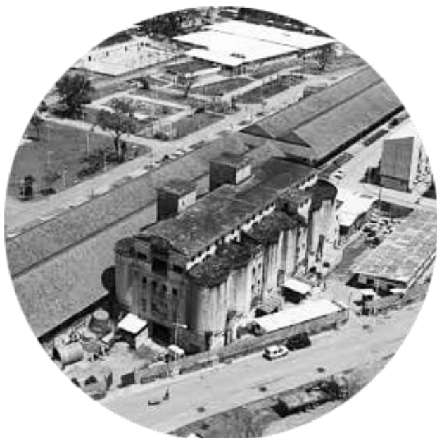
Figura 46: Cobertura do silo. FONTE: Perfil do Facebook.
