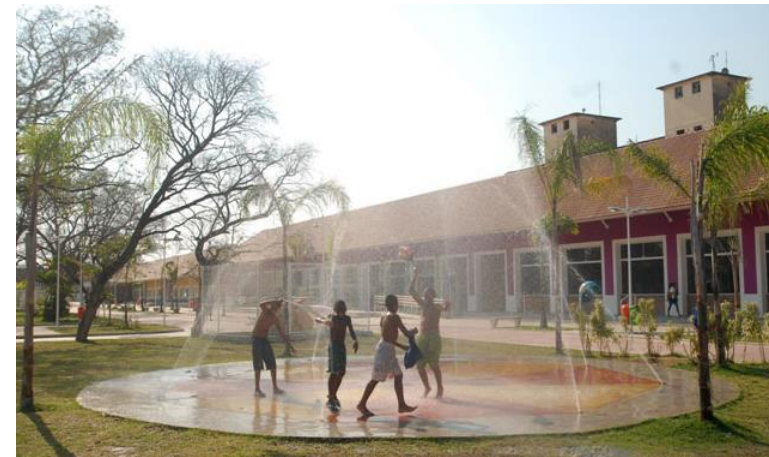
Figura 8: Praça do DSUP, em frente à Biblioteca, após as obras. FONTE: Jorge Jauregui/Divulgação.
