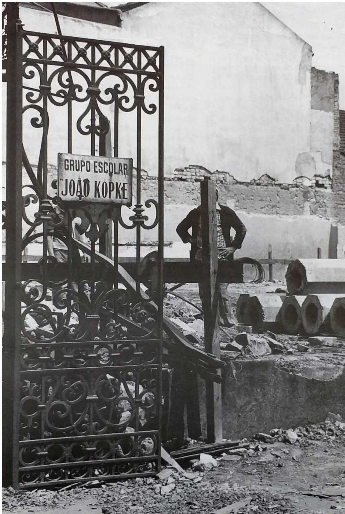
Figura 64- (1976-1978) EEPG João Kopke: demolição gradativa junto da construção do novo edifício enquanto a escola permanecia em funcionamento.
