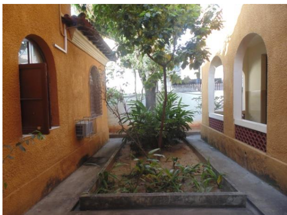
Figura 118: o pátio entre o conjunto edificado. Fonte: Arquivo do autor (2015).
