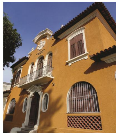
Foto 1: Fachada principal da Escola Municipal Sarmiento.
