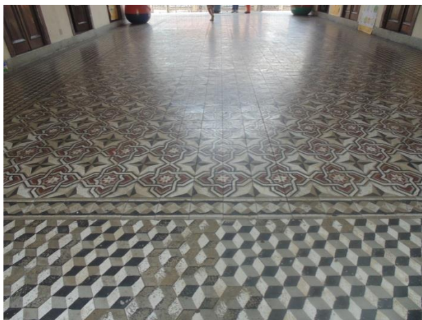
Figura 95: O piso original do pátio central coberto Fonte: Arquivo pessoal do autor (2015).
