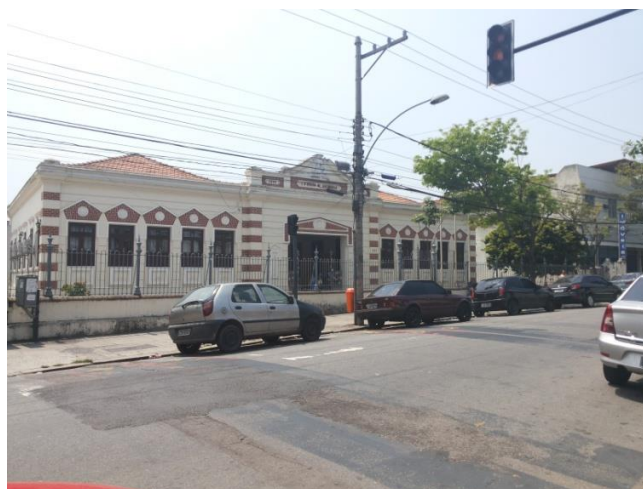
Figura 96: a relação da escola com o entorno. As grades baixas que acabam deixando a escola muito exposta Fonte: Arquivo do autor (2015).
