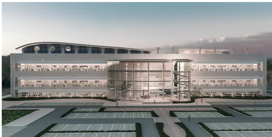
Imagem 58: CDTS. Maquete virtual. Vista da Edificação Principal. Fonte: Acervo PAAL (2019).
