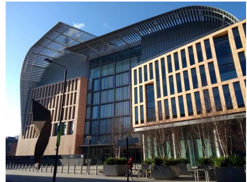
Imagem 33: Proteções contra radiação solar usadas para definir a forma do edifício. Francis Crick Institute, Londres, Inglaterra. Fonte: Acervo do autor (2018).
