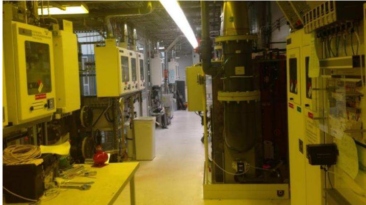
Imagem 9: Vista da galeria de controles de sistemas. Koch Institute (MIT), Cambridge, EUA. Fonte: Acervo do autor (2016).
