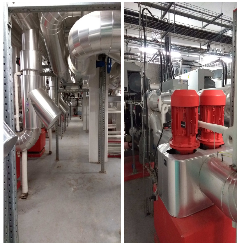
Imagem 8: Vistas do pavimento técnico. Edifício François Jacob, Instituto Pasteur, Paris, França. Fonte: Acervo do autor (2018).
