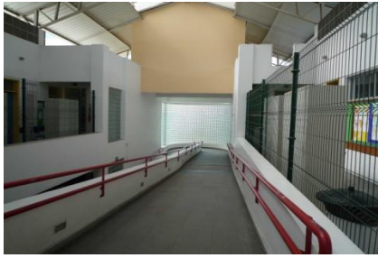
Figura 13 - Rampa central de acesso aos pavimentos
