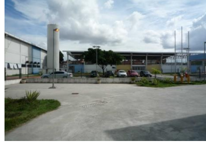
Figura 14- Área externa pavimentada
