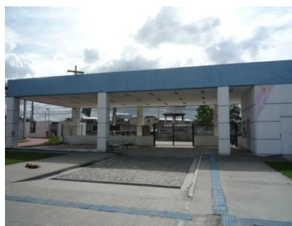
Figura 12 - Guarita de acesso
