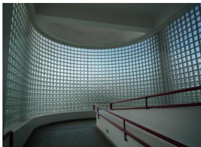
Figura 15 - Blocos de vidro no fechamento da rampa
