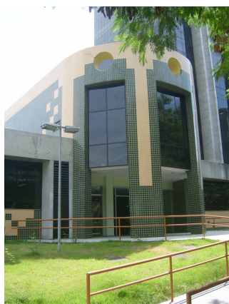
Fig. 1 - Fachada frontal Rua Afonso Cavalcanti
