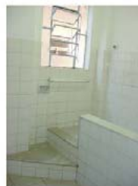
Foto 03: Box dos chuveiros
