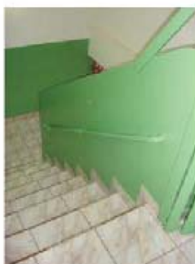
Foto 01: Detalhe do corrimão
