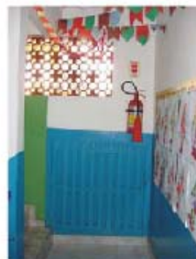
Foto 03: Acesso à escada
