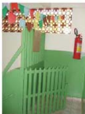
Foto 01: Acesso à escada
