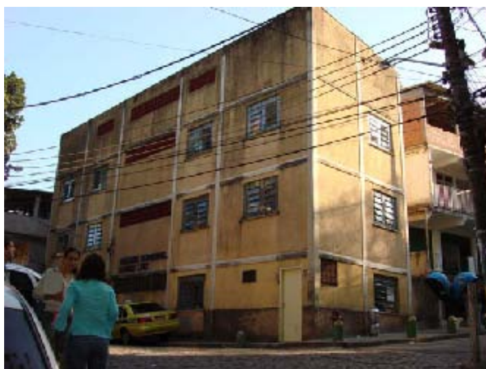
Foto 2: Fachada frontal da creche.
