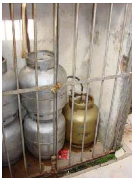
Foto 8: Abrigo do Gás.
