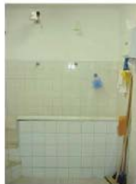
Foto 03: Box dos chuveiros
