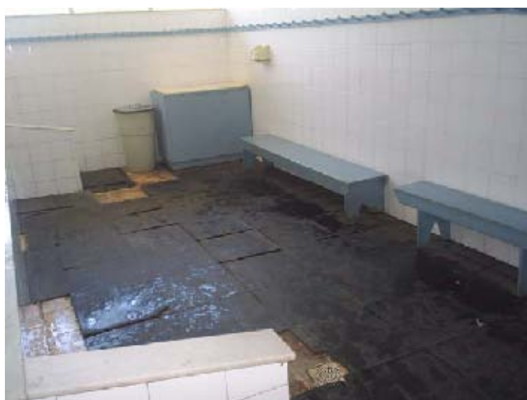
Figura 07 – Materiais de acabamento do banheiro das crianças em estado precário
