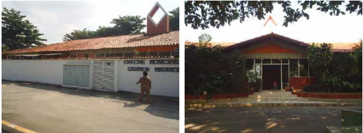
Figura 02 – Entrada da Creche e vista do pátio
