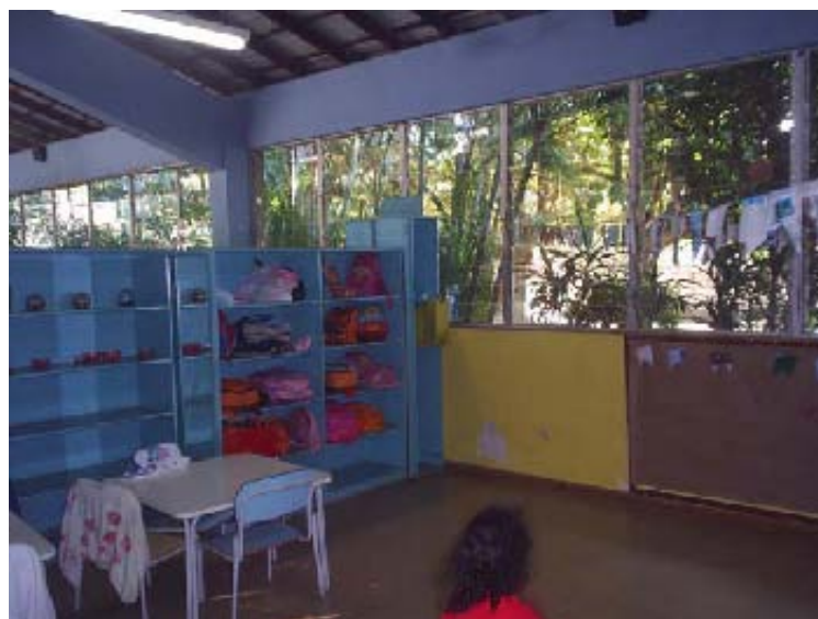
Figura 10 – A divisão entre as salas é feita com estantes de madeira e não há forro, o que faz aumentar a propagação do ruído
