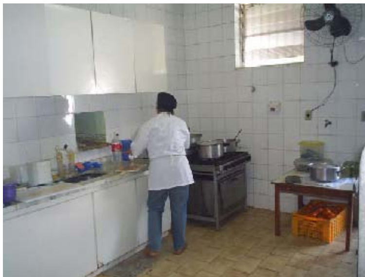
Figura 13 – O tamanho da janela da cozinha é insuficiente para ventilar o ambiente. Foi necessário instalar um ventilador de parede
