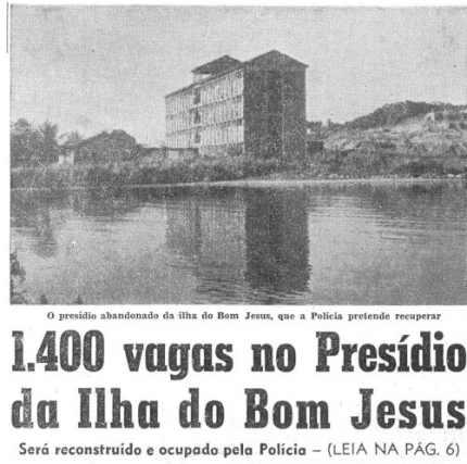
Figura 7: Estrutura de concreto do Presídio.
