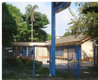
Figura 3: Vista do acesso à Escola com destaque para os blocos horizontais.
