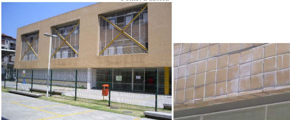
Figura 29: Fachada Lateral. Percebe-se claramente a marcação das vigas no revestimento
