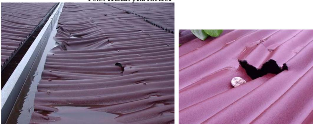
Figura 33: Telhas de fibras vegetais em cobertura de escola tipo “Lelé”
