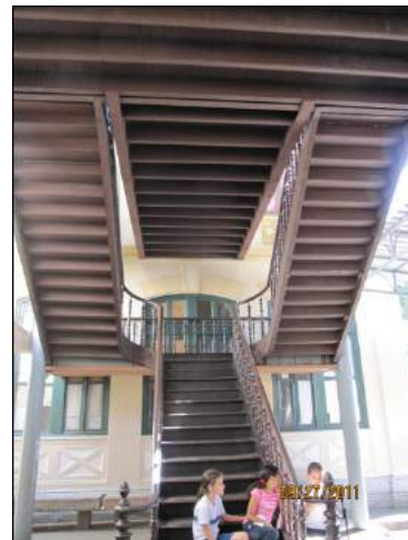
Figura 135: escada para o segundo pavimento. Fonte: GAE. 2011.
