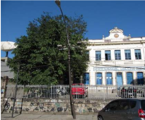
Figura 44: pátio 01 – vista da via de acesso. Fonte: GAE. 2010.
