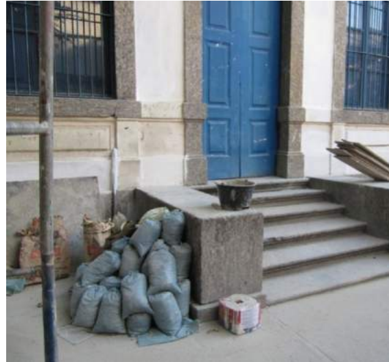
Figura 57: obras na escola. Fonte: GAE. 2010.
