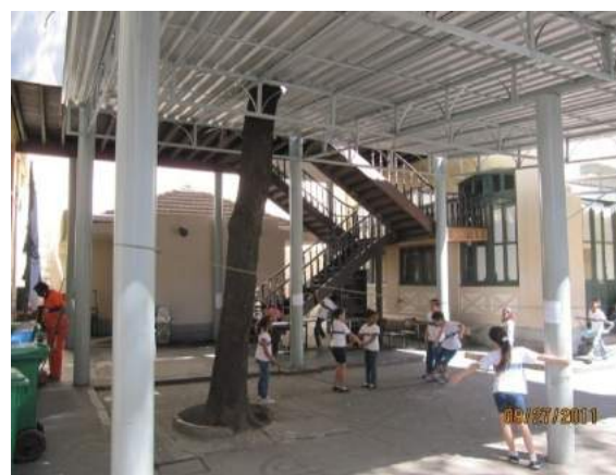
Figura 101: Aproveitamento dos pilares da cobertura metálica. Fonte: GAE. 2011.
