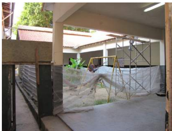
Figura 36: pátio em obras. Fonte: GAE. 2010.
