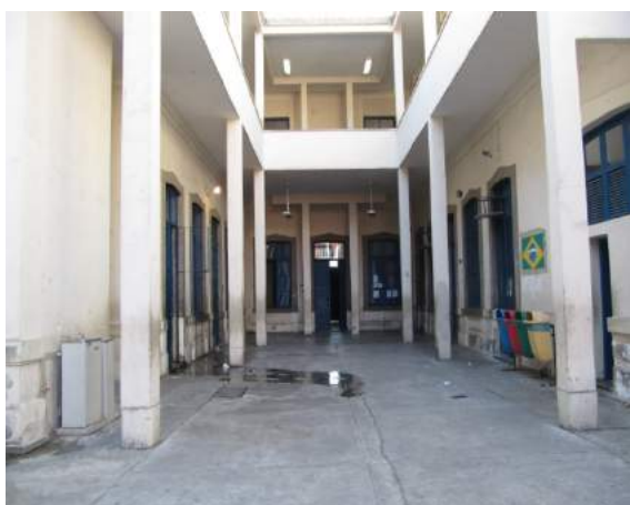
Figura 54: acesso pelo “miolo” da edificação. Fonte: GAE. 2010.
