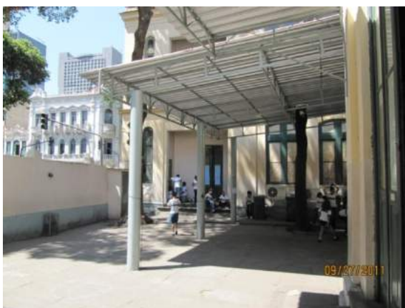
Figura 70: cobertura metálica. Fonte: GAE. 2011.
