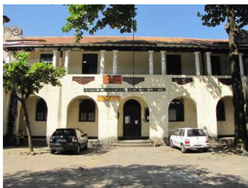
Figura 27: acesso por arcadas frontais. Fonte: GAE. 2010.
