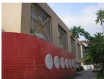
Figura 19-Foto da fachada lateral esquerda.
