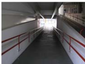
Figura 55-Foto da vista rampa do Térreo ao 1º Pavimento.
