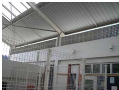
Fig. 108 – Cobertura apoiada nas paredes c/ cobogós.
