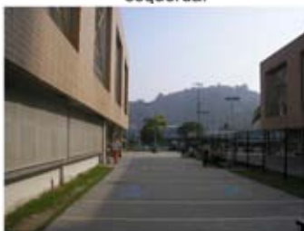
Figura 22-Foto da fachada lateral direita, nos fundos Av. Pres. Vargas.
