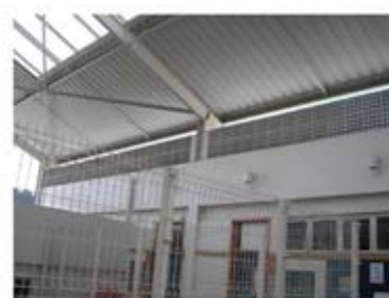
Figura 60-Foto do detalhe do encontro da Cobertura c/ a Alvenaria.
