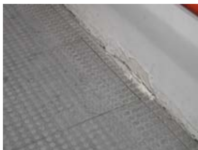
Fig. 74 – Pinturas cedendo na rampa e na parede próxima a cobertura.
