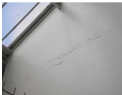
Fig. 74 – Pinturas cedendo na rampa e na parede próxima a cobertura.
