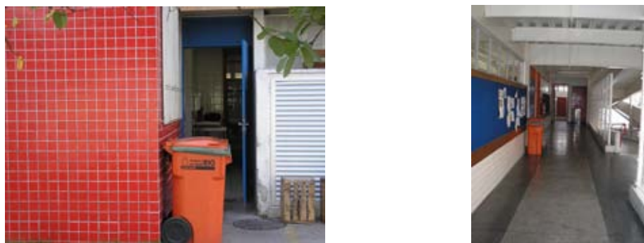
Fig. 77 – Contêineres de lixo na parte externa da área de serviço e na circulação.
