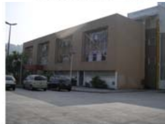
Figura 24-Foto da fachada lateral esquerda e estacionamento.
