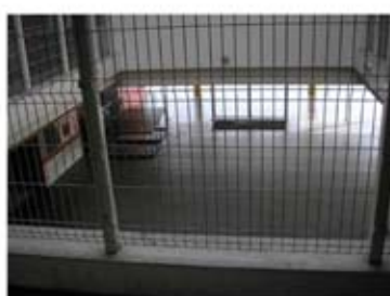
Figura 59-Foto da vista Mezanino do 1º Pavimento p/ o Térreo.
