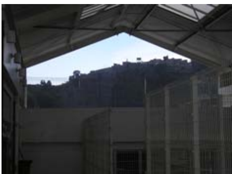
Fig. 106 – Cobertura termo- acústica
