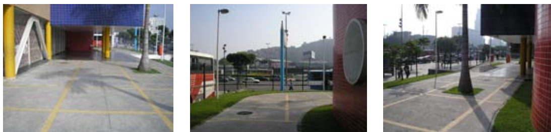
Fig. 88 – Detalhe da Pavimentação da área externa da Escola.
