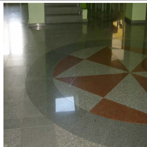
Fig. 62 – Detalhe do piso de granito do Hall de Entrada (foto da autora 2007)
