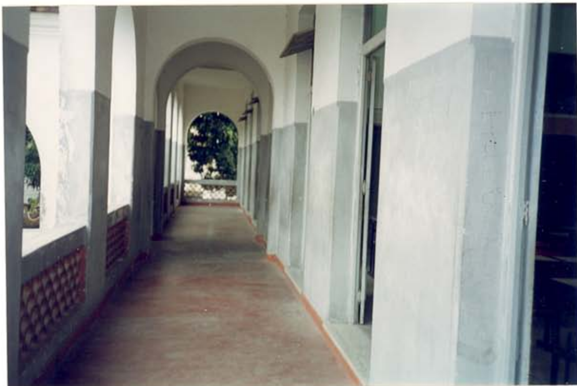
Figura IV.14 - Salas de aula dispostas para varandas em arcadas (Foto da autora, novembro/1994)
