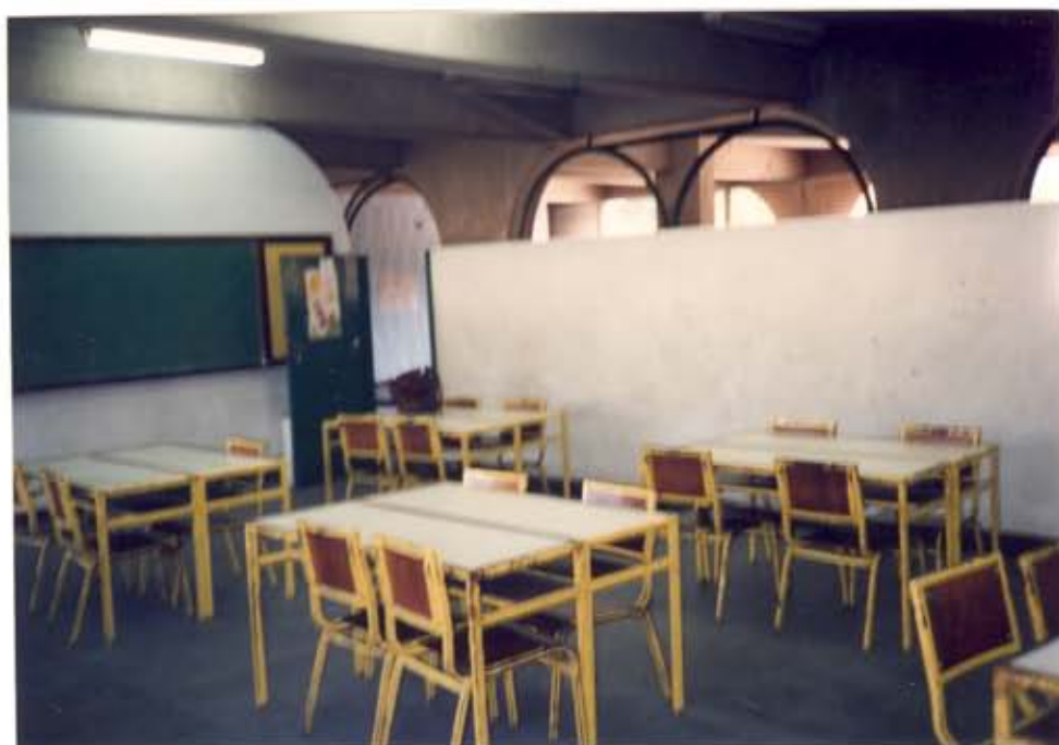
Figura IV.41 - Detalhe das divisões internas das salas de aula (Foto da autora, maio/1994)
