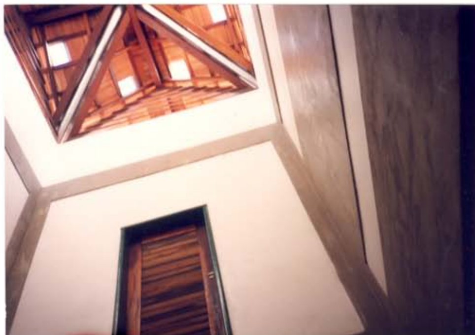
Figura IV.58 - Detalhe do lanternim, no eixo de circulação (Foto da autora, abril/1994)
