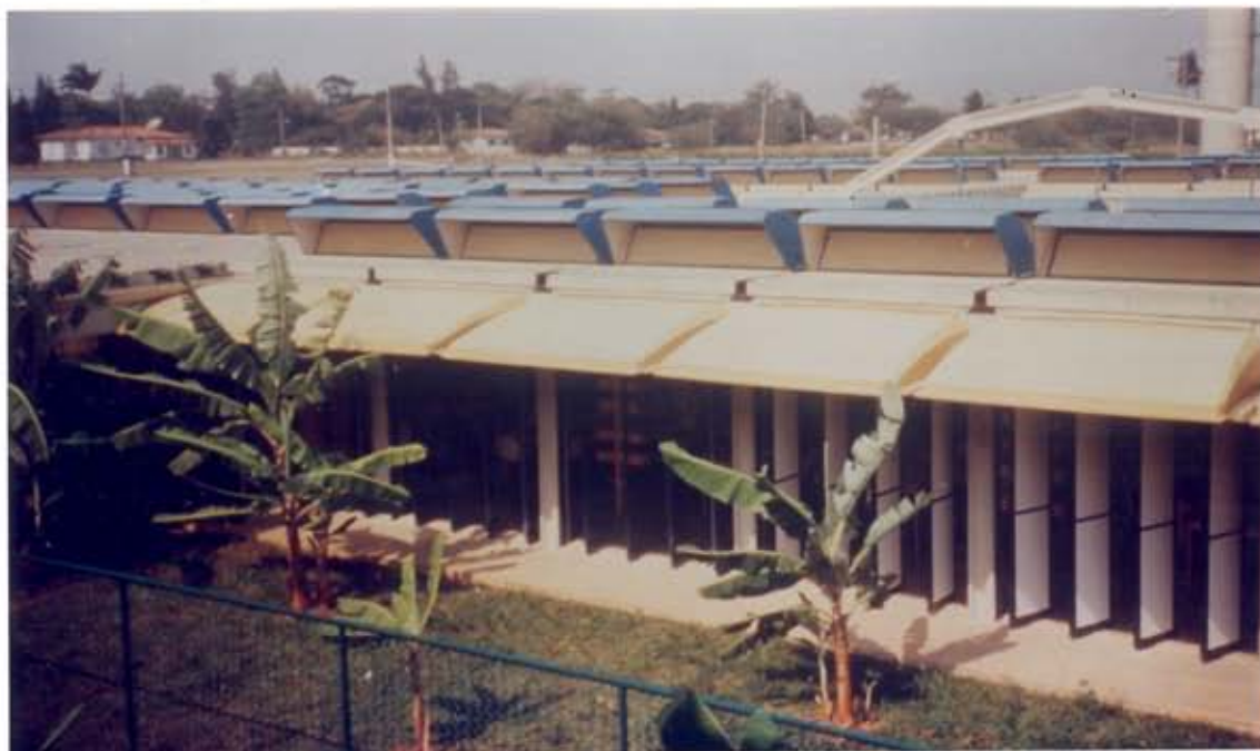
Figura IV.68 - Detalhe dos sheds da cobertura (Foto da autora, setembro/1994)
