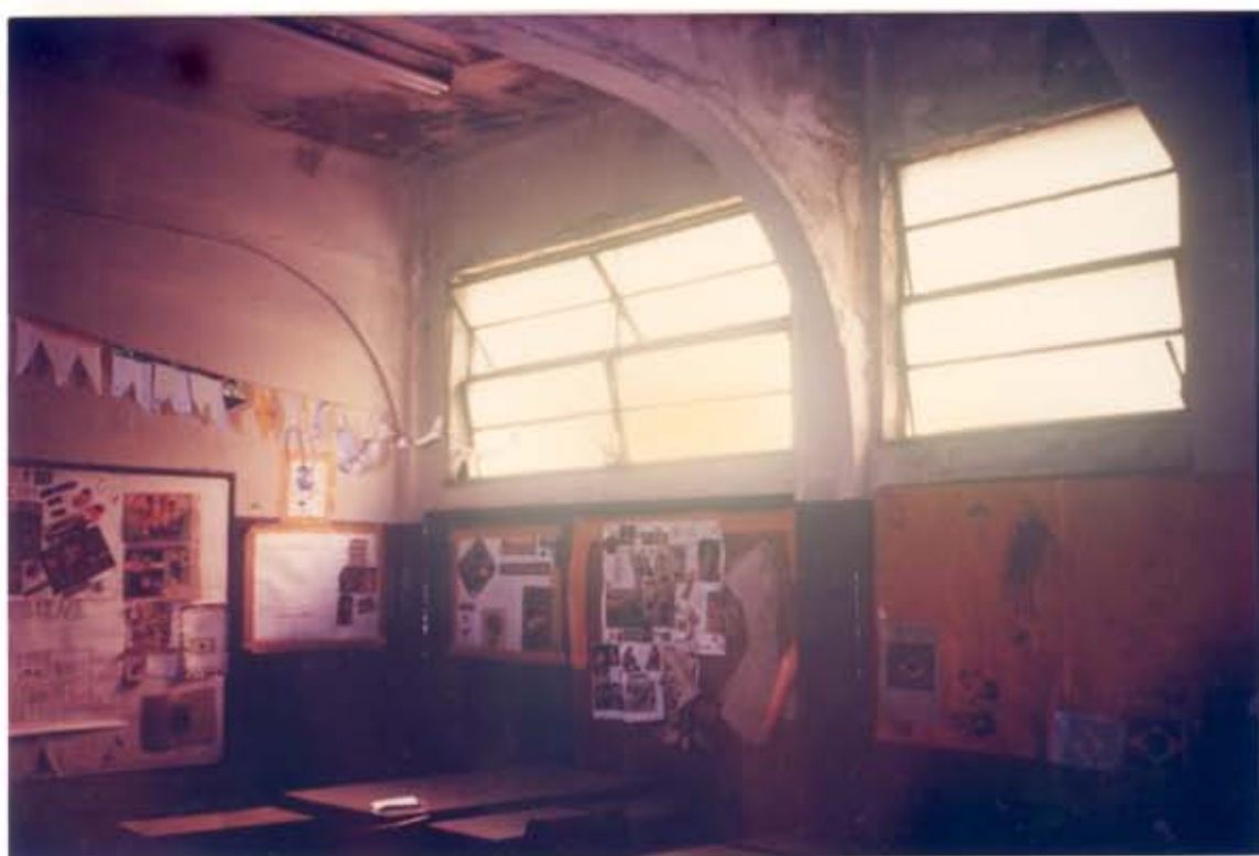
Figura IV.22 - Interior da sala de aula (Foto da autora, junho/1994)
