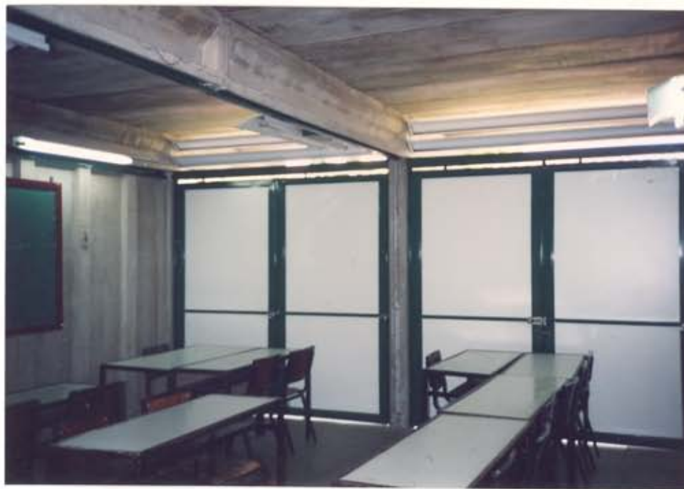
Figura IV.50 - Interior da sala de aula - portas pivotantes fechadas (Foto da autora, maio/1994)
