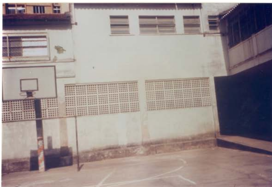
Figura IV.20 - Disposição dos blocos no terreno (Foto da autora, junho/1994)
