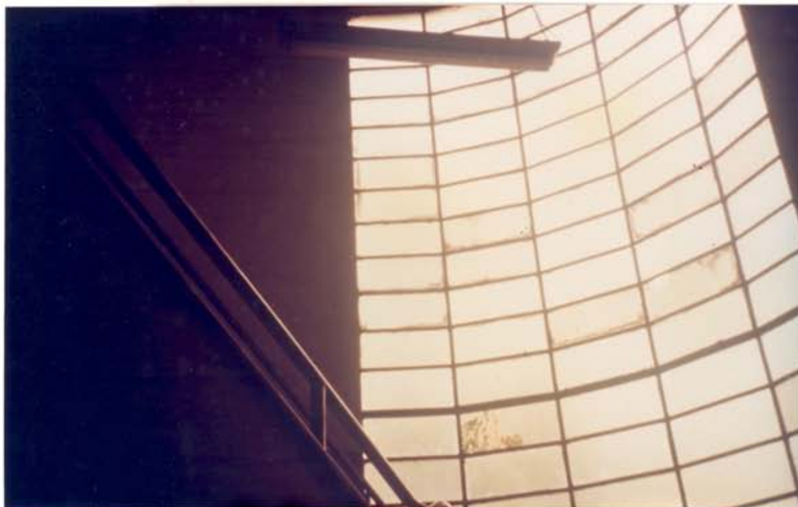
Figura IV.16 - Detalhe da circulação vertical - (escadas com painel em ferro e vidro fixo, foto da autora, junho/1994)
