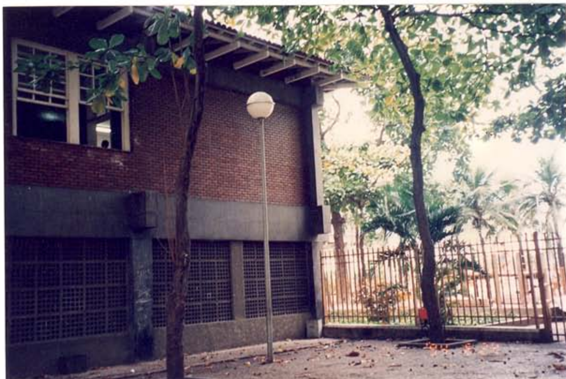
Figura IV.32 - Aspecto externo da edificação (Foto da autora, junho/1994)
