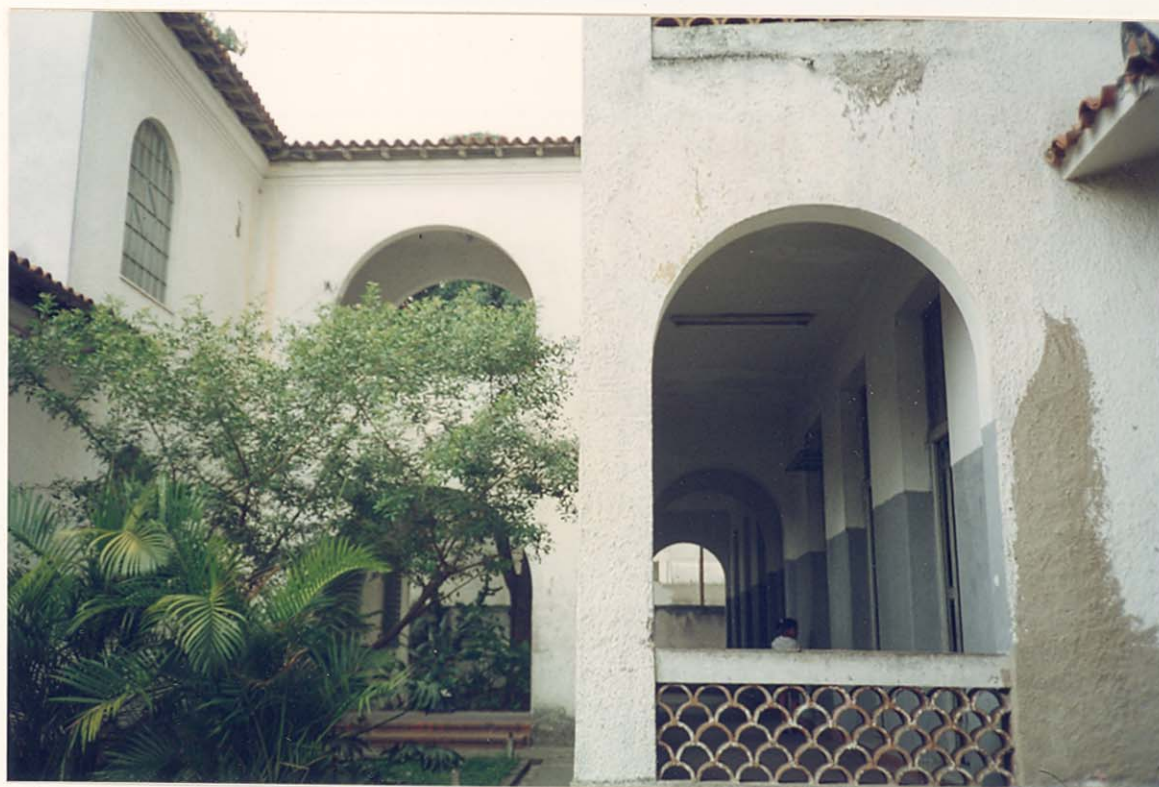
Figura IV.10 - Aspecto externo da edificação - vista lateral (Foto da autora, novembro/1994)
