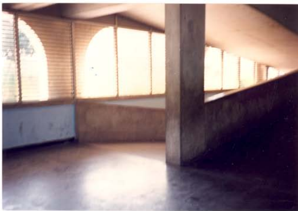
Figura IV.42 - Circulação / rampa de acesso (Foto da autora, maio/1994)
