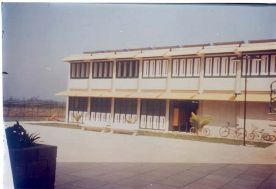
Figura IV.66 - Aspecto externo da edificação - insolação da fachada (Foto da autora, setembro/1994)
