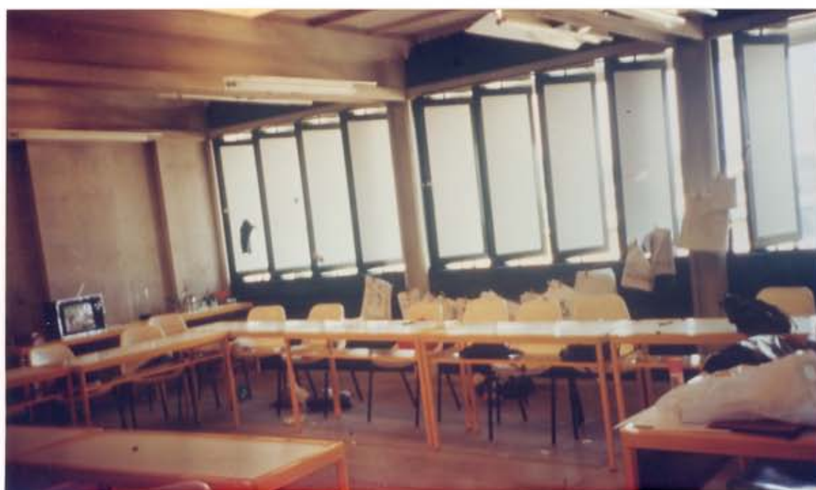
Figura IV.69 - Aspecto interno das salas de aula - det. das janelas pivotantes (Foto da autora, setembro/1994)
