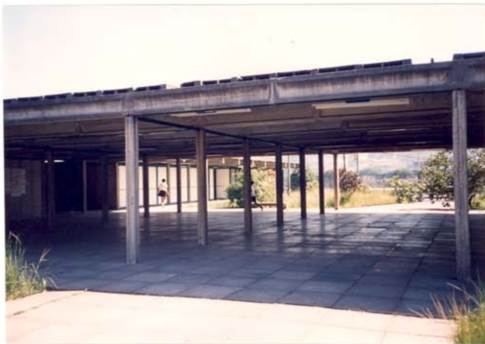
Figura IV.44 - Pátio coberto central (Foto da autora, maio/1994)
