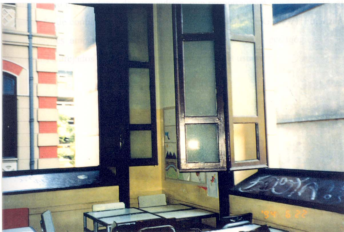
Figura IV.6 - Interior da sala de aula / Detalhe das esquadrias
