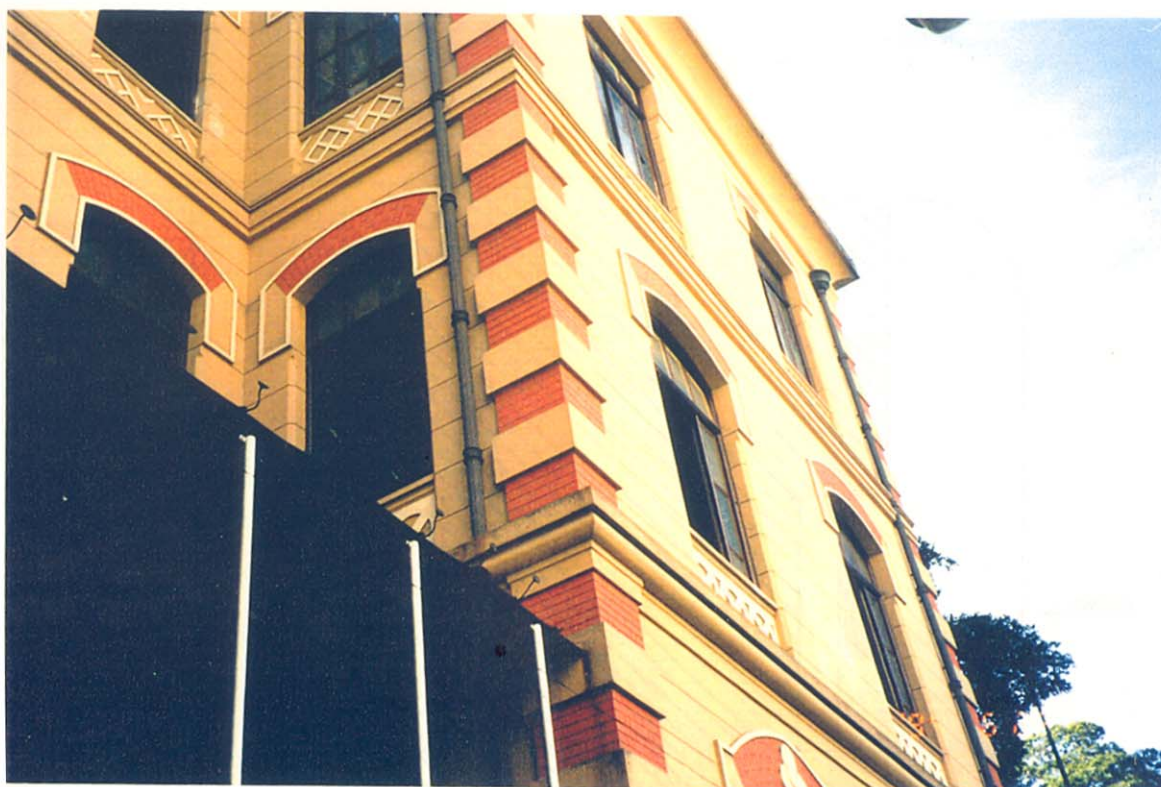
Figura IV.1 - Aspecto externo da edificação (Foto da autora, junho/1994)
