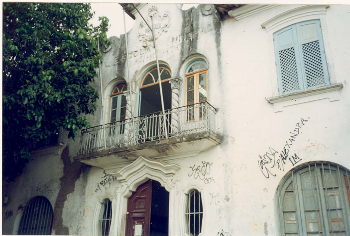
Figura IV.9 - Aspecto externo da edificação - fachada principal (Foto da autora, novembro/1994)
