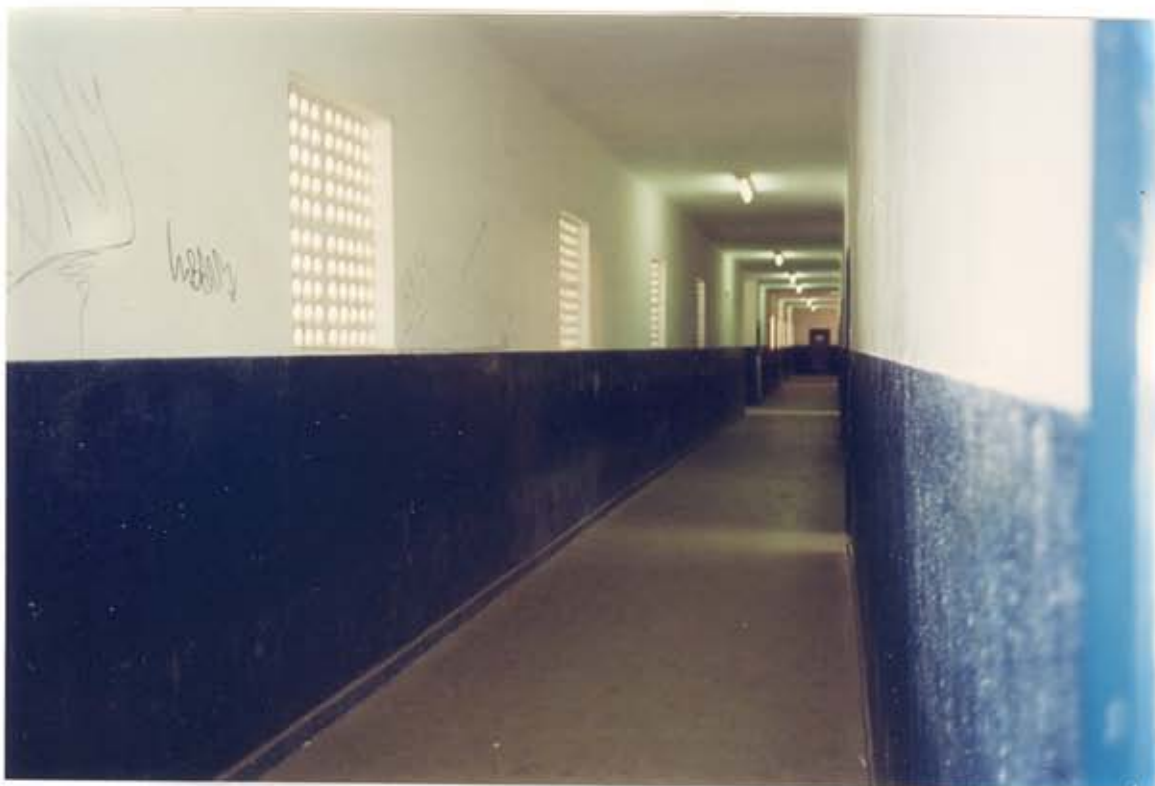
Figura IV.29 - Detalhe dos combogós na circulação (Foto da autora, novembro/1994)
