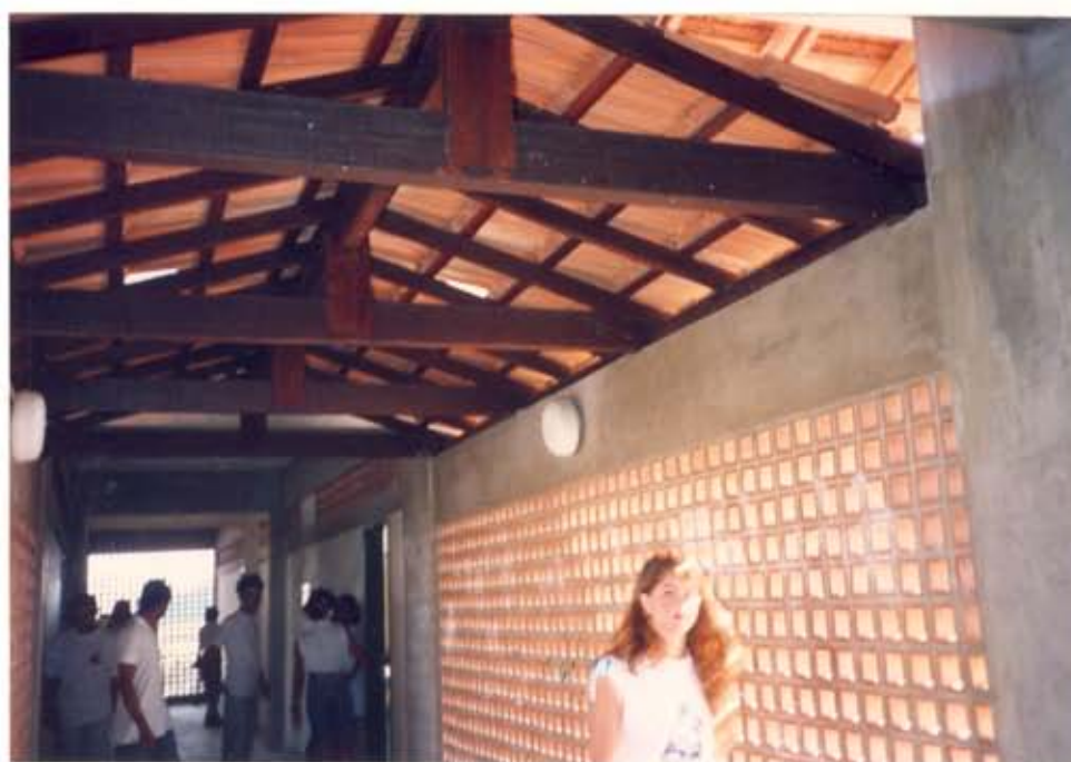
Figura IV.60 - Combogós cerâmicos visando ventilação cruzada - circulação (Foto da autora, abril/1994)
