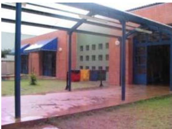
Fig.137- Detalhe da água no piso da circulação
