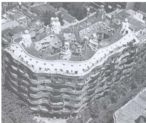
Fig. 3.8: Casa Milà, Barcelona, 1906-10 (HERTZBERGER, 1999, p. 123)
