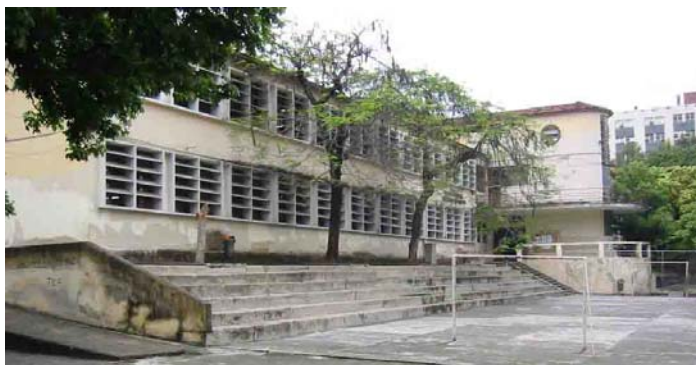
Fig. 4.41: EM República Argentina – Trecho da fachada principal (foto do autor em 17/11/2004).
