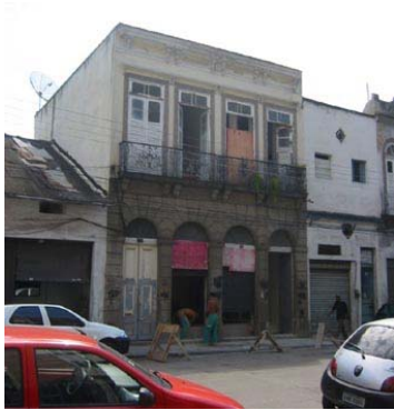
Fig. 3.52: Rua Sacadura Cabral, 295 – Fachada (foto do autor).
