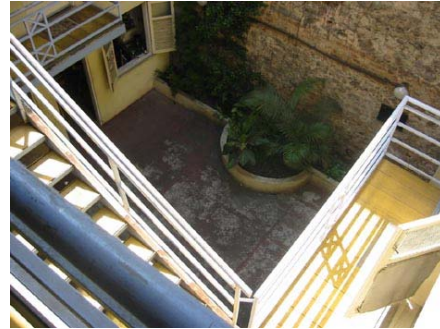
Fig. 3.53: Rua Sacadura Cabral, 295 – Pátio interno (foto do autor).
