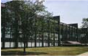
Fig. 1.2: Crown Hall, Chicago, Illinois. L. Mies Van der Rohe. (www.google.com.br)
