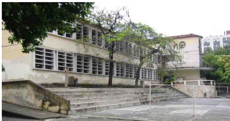
Fig. 4.13- EM República Argentina: Trecho da Fachada Principal (foto do autor em 17/11/2004).
