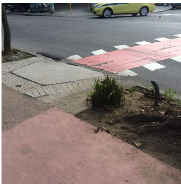
Figura 41 -Rampa para “acessibilidade”
