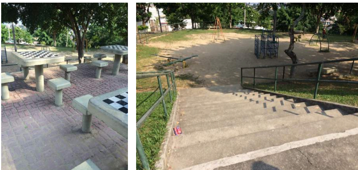
Figuras 56 e 57 – Falta de acessibilidade ao playground. Fonte: SBARRA, 2016.
