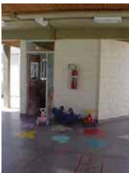
Figura 78 – Detalhe do extintor de incêndio
