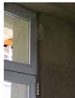
Figura 83 – Detalhe da parede do refeitório
