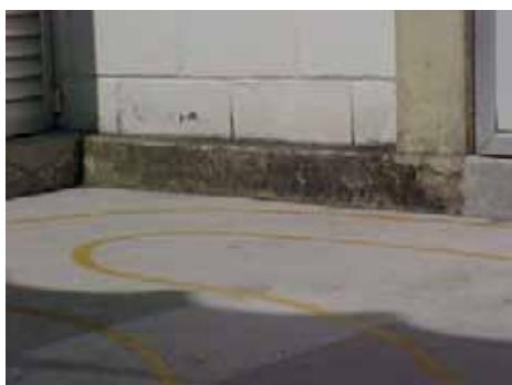
Figura 96 – Detalhe do piso da área descoberta
