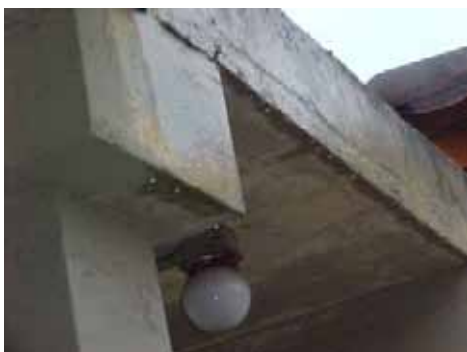
Figura 105 – Detalhe do caimento de água
