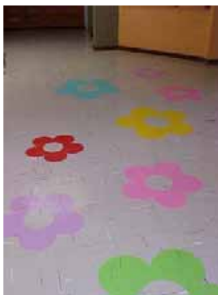
Figura 55 – Detalhe do piso
