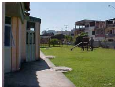
Figura 113 – Detalhe do fechamento do pátio externo
