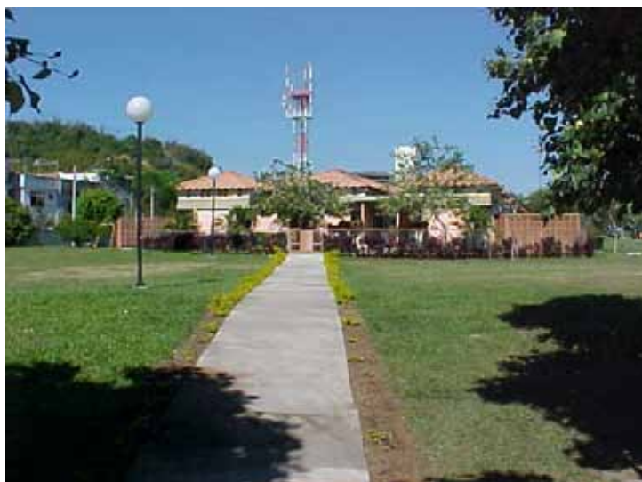
Figura 2- Vista Frontal da Creche UFF
