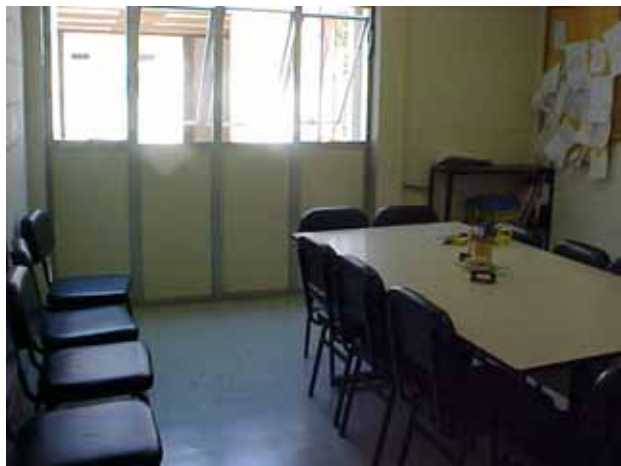
Figura 50 – Piso da sala de reuniões
