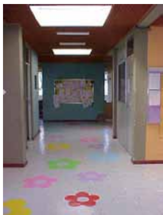
Figura 54 – Piso da circulação
