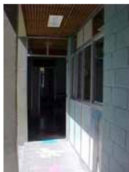
Figura 74 – Detalhe da janela de correr
