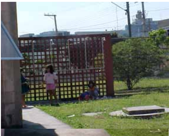
Figura 25 – Detalhe da parede cobogó e da grade
