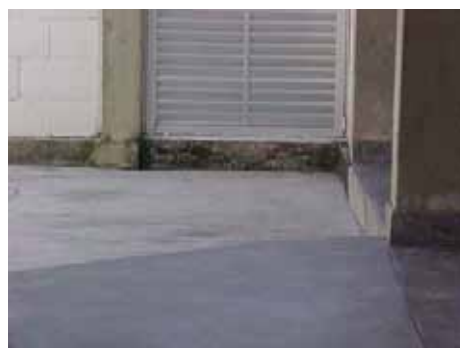
Figura 97 – Detalhe do piso da área descoberta
