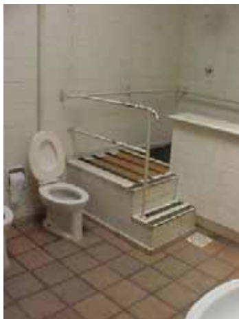
Figura 46 – Detalhe das faixas anti-derrapantes nos degraus
