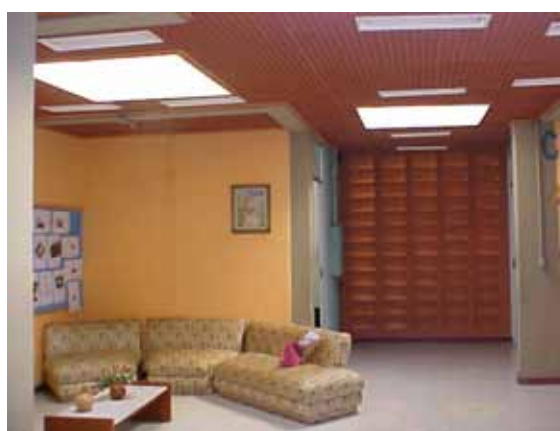
Figura 63 – Presença de clarabóias, tijolos vazados e luminárias fluorescentes
