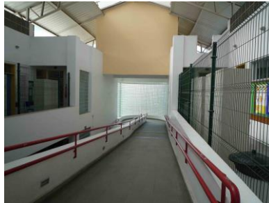
Figura 9 - Circulação bem iluminada porém ineficiente em conforto térmico
