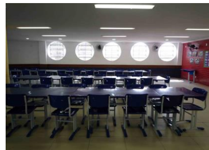
Figura 10 - Aberturas do refeitório impedem ventilação adequada do espaço
