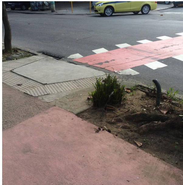
Figura 6 -Rampa para “acessibilidade”
