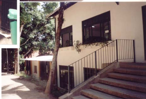
Figura 22 : Escadas de acesso: Jardim/Maternal, Bloco 1 a a 4 a , circulação pedestres.
