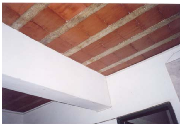
Figura 35: Detalhe teto Direção Pedagógica – laje pré-moldada sem revestimento
