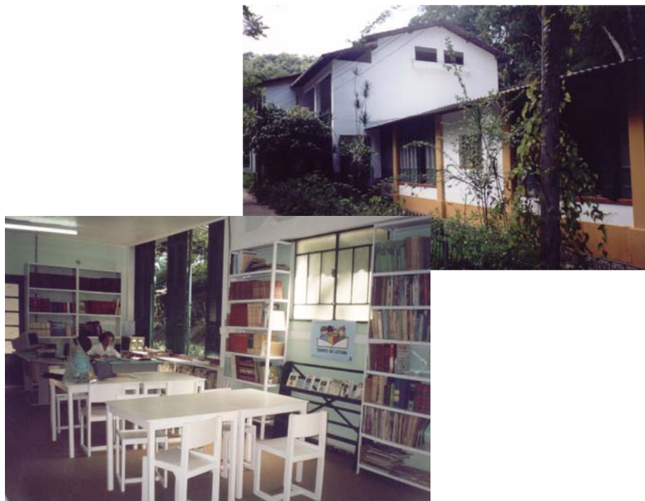
Figura 29 – Biblioteca: Vista externa e ambientação interna.
