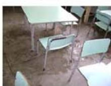
Foto 04: Poças d'água causadas pela infiltração de água
