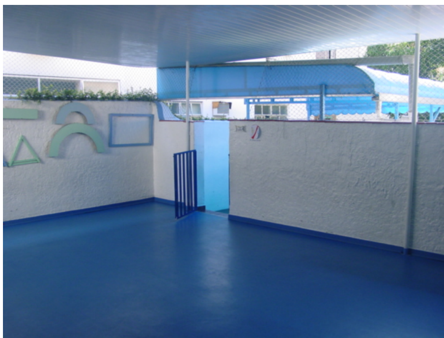
Foto 35: Vista do acesso a Oficina do Movimento e das aberturas existentes
