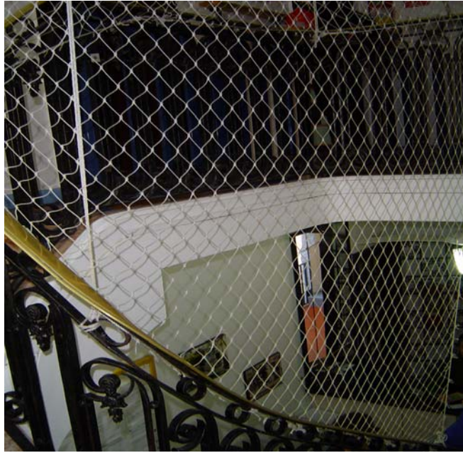
Foto 13: Vista da tela da escada
