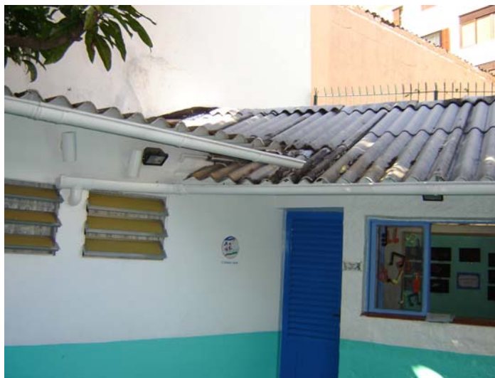
Foto 10: Vista dos beirais e calhas do anexo
