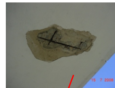
Reparos importantes: patologias construtivas (corrosão da armadura)
