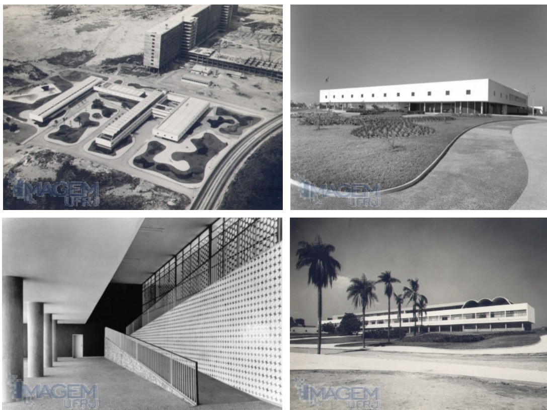
Figuras 2, 3, 4 e 5: vistas do Instituto de Puericultura e Pediatria Martagão Gesteira. Fotos em sentido horário: vista aérea da construção do Hospital Universitário Clementino Fraga Filho (HUCFF) e do IPPMG; fachada do IPPMG; rampas de acesso às salas de aula; fachada do IPPMG. Fonte: Coordenadoria de Comunicação da UFRJ. Disponível em: www.imagem.ufrj.br . Acesso em: 28 de julho de 2008.
