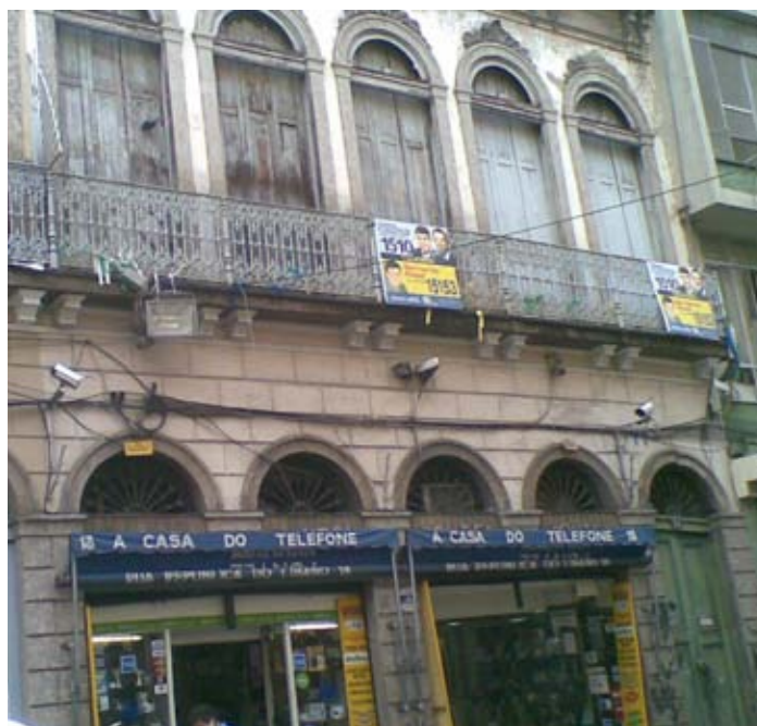
Figura 28 - Fachada de edifício no entorno da escola.
