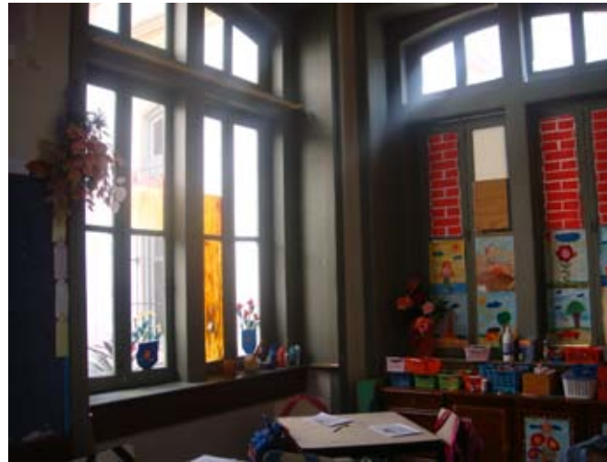
02- Paredes a norte são tapadas para melhor conforto térmico.
