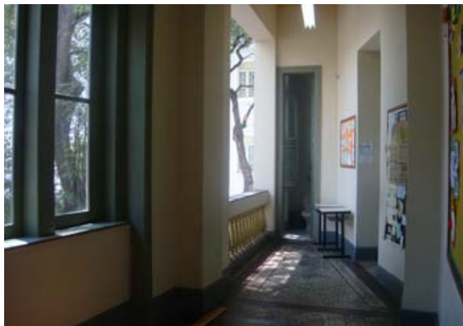
07- Circulação de acesso às salas e banheiro da ala esquerda. Destaque para o piso em ladrilho hidráulico no trecho com balaustrada e em tábua corrida no trecho com janelas.
