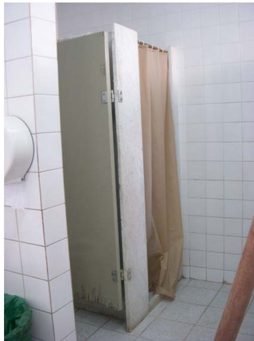
02- Cabine do chuveiro funciona como depósito
