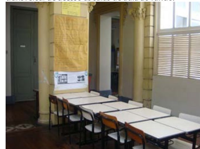
06- Piso em ladrilho hidráulico separando a circulação central que une os dois edifícios e a circulação pertencente apenas ao edifício frontal.
