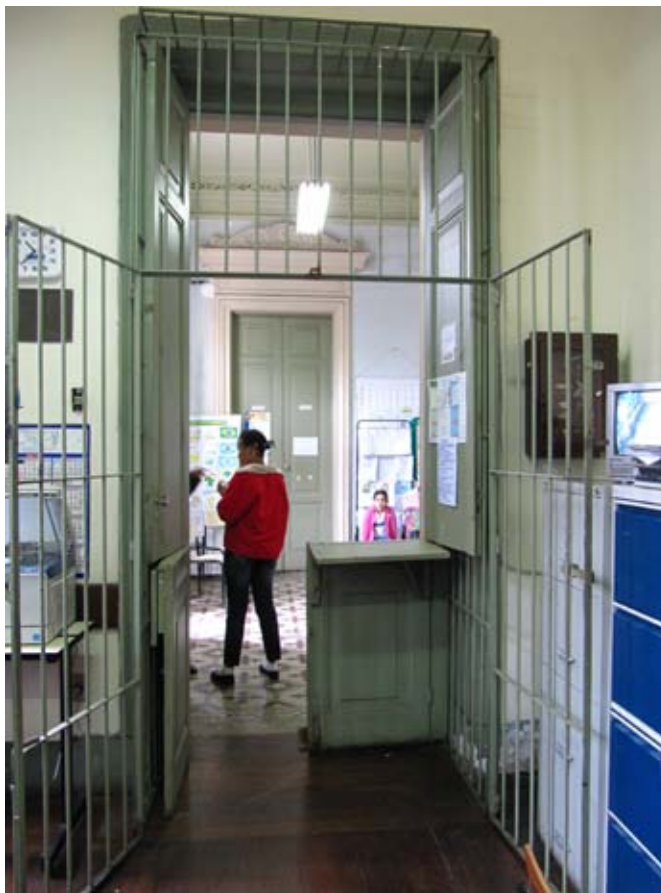
02- Gradeamento nas portas da diretoria
