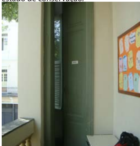
05- Acesso ao banheiro do 2º pavimento
