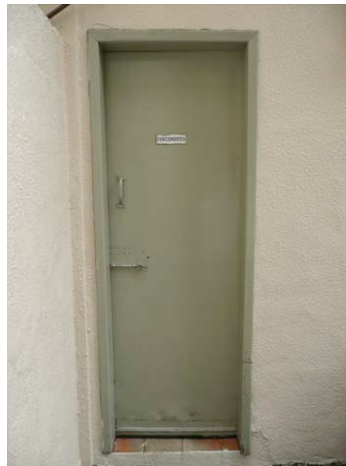
02- Porta de acesso ao banheiro do refeitório pela área externa
