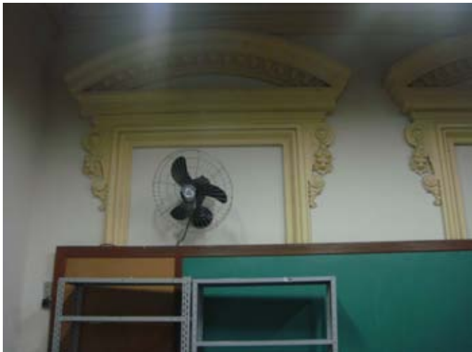
04- Vãos de porta fechados com alvenaria. Ornatos escondidos por mobiliário
