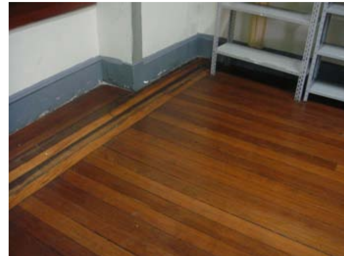
06- Detalhe do piso de madeira
