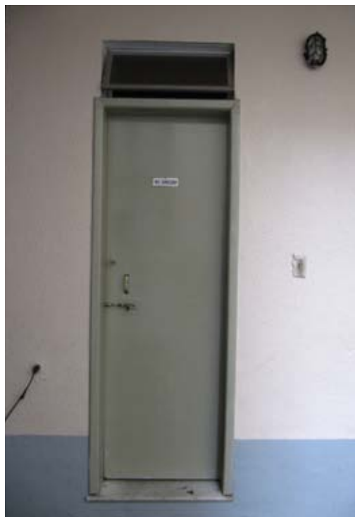
02- Porta de acesso com abertura superior
