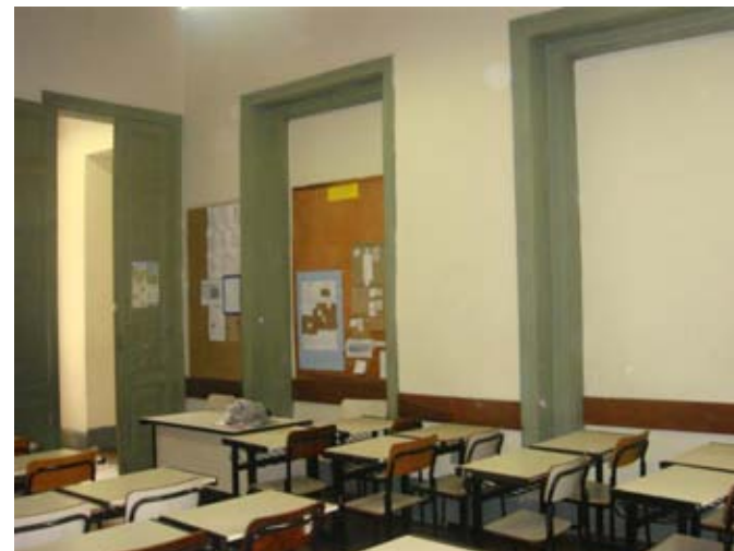
06- Mesa da professora disposta lateralmente em vão de porta fechado em alvenaria
