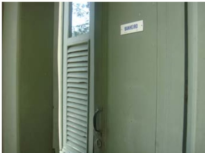
04- Porta com placa de identificação e fechadura de sobrepor. Janela de madeira com veneziana e vidro.
