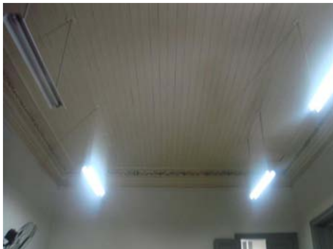
04- Detalhe do teto e da iluminação
