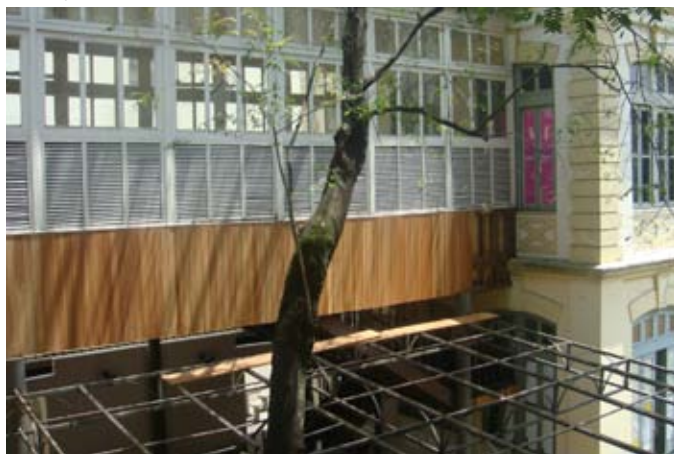
10-Vista externa da circulação central a partir da janela da ala esquerda em 05/10/10. Substituição do revestimento de madeira da circulação.
