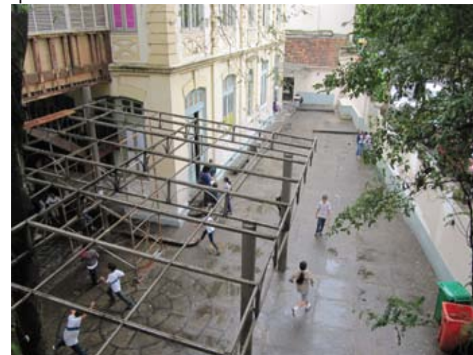
08- Coberturas do pátio em período de reforma.
