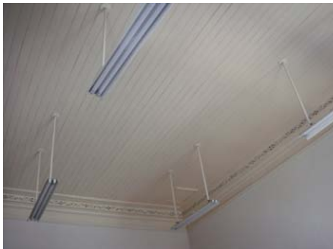
01- Detalhe do teto com forro, sanca, alçapão, luminárias
