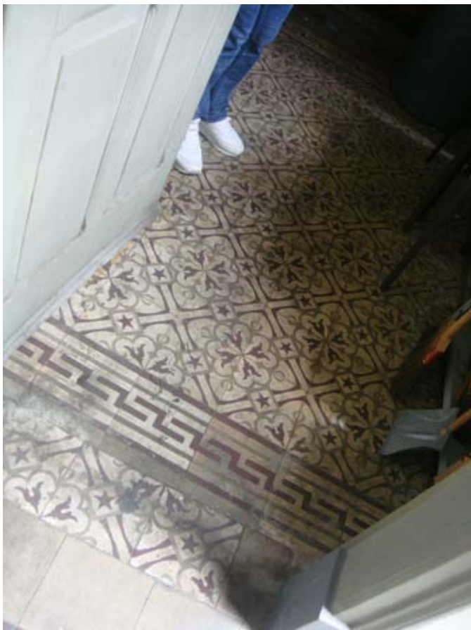
01- Piso em ladrilho hidráulico
