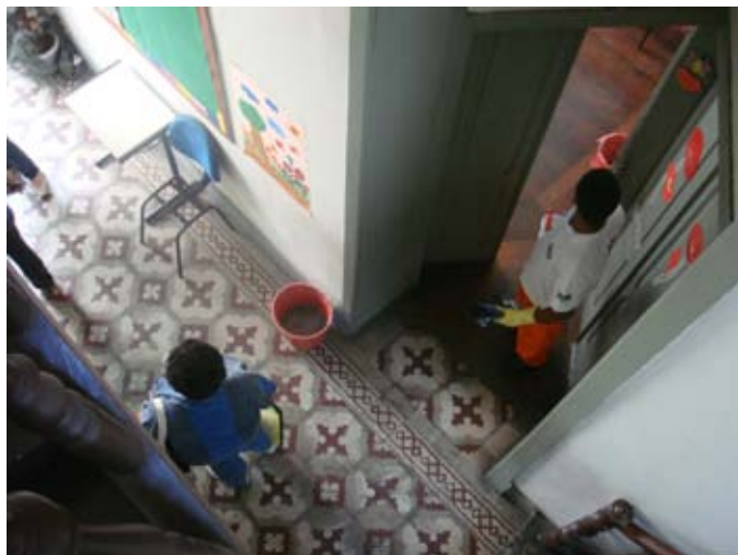
01- Acesso às salas do piso térreo, visto do 1ª piso.
