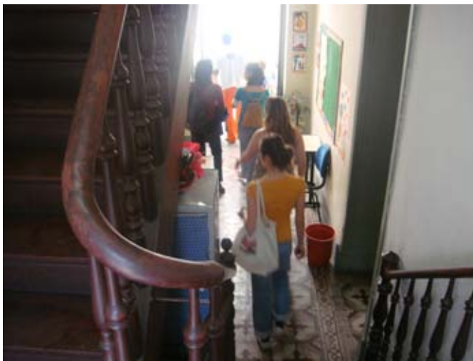
02- Acesso ao primeiro piso
