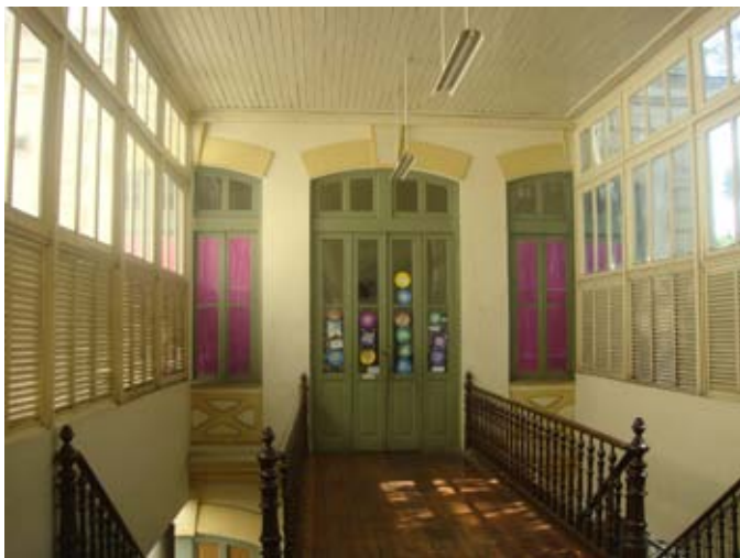
01- Destaque para o fechamento lateral da circulação que intercepta os vãos das janelas e ornatos.
