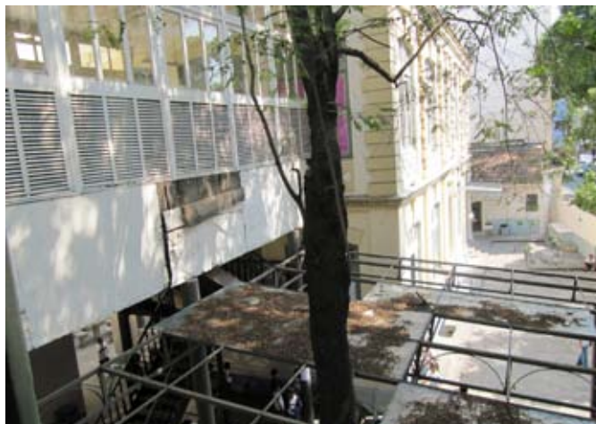
08- Vista externa da circulação central a partir da janela da ala esquerda em 21/09/10.
