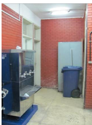
Figura 12 - Foto do acesso ao banheiro masculino e zeladoria.
