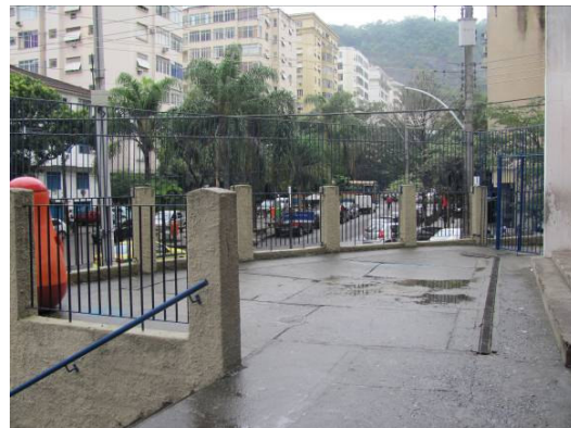
Figura 15 - Foto do pátio frontal (acesso a pátio lateral esquerdo).
