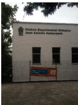
(a) Acesso principal da escola
