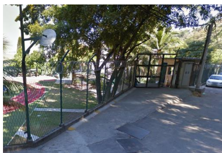
(b) Guarita e portão de acesso à escola
