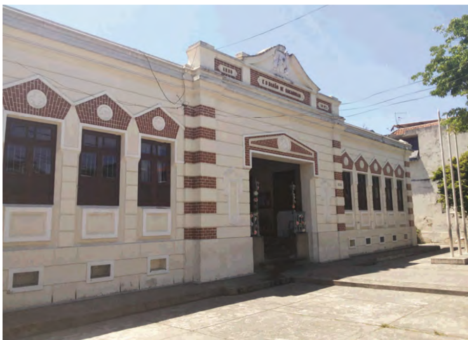
Figura 1 – Fachada principal da escola
